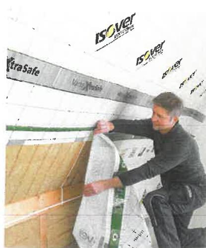
Zum Schutz der Bausubstanz und für ein gutes Wohnraumklima unter den Schrägen wird eine Dampfsperre auf der Rauminnen-seite aufgebracht. Saint Gobain Isover
